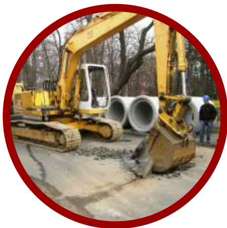
Наставак радова на изградњи каналizacione инсталације отпадних вода у насељу Алибунар
